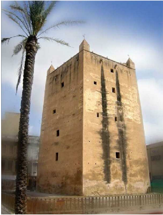
Figura 1.- Torre Torrent. Estado anterior a la restauración (Fotografía de archivo de la UPV).
