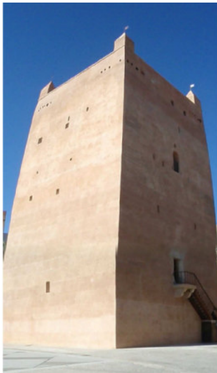
Figura 3.- Torre de Torrent. Estado actual. (Fotografía de archivo de la UPV).
