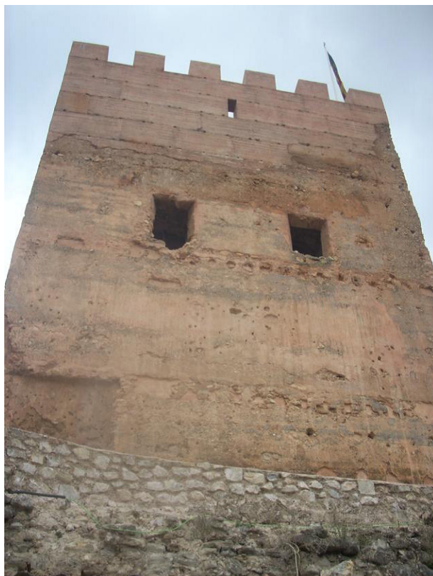
Figura 8.- Torre Sot de Chera, Fotografía actual cara Norte. (Fotografía de archivo de la UPV).
